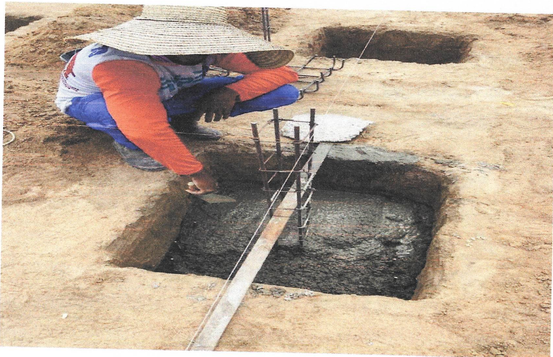
Foto 04 – EXECUÇÃO DE ESTRUTURAS DE CONCRETO ARMADO, PARA EDIFICAÇÃO HABITACIONAL UNIFAMILIAR TÉRREA
