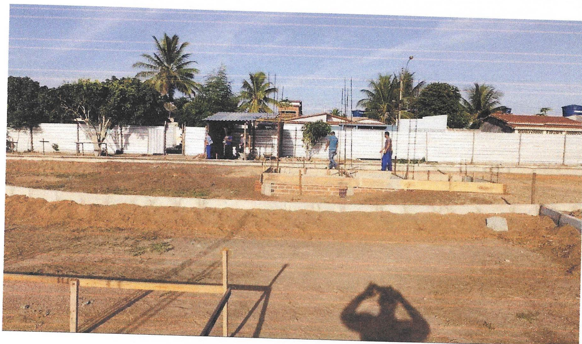
Foto 17 - Meio-fio pré moldado de concreto simples e aterro manual de valas.
