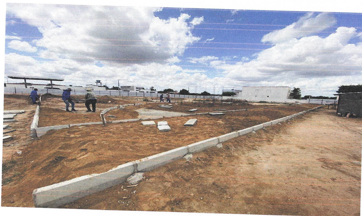
Foto 18 - ATERRO MANUAL DE VALAS COM AREIA PARA ATERRO E COMPACTAÇÃO MECANIZADA.
