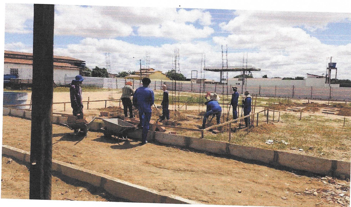
Foto 16 – EXECUÇÃO DE ESTRUTURAS DE CONCRETO ARMADO.
