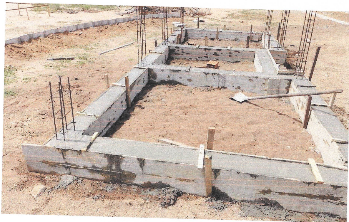
Foto 15 – EXECUÇÃO DE ESTRUTURAS DE CONCRETO ARMADO.
