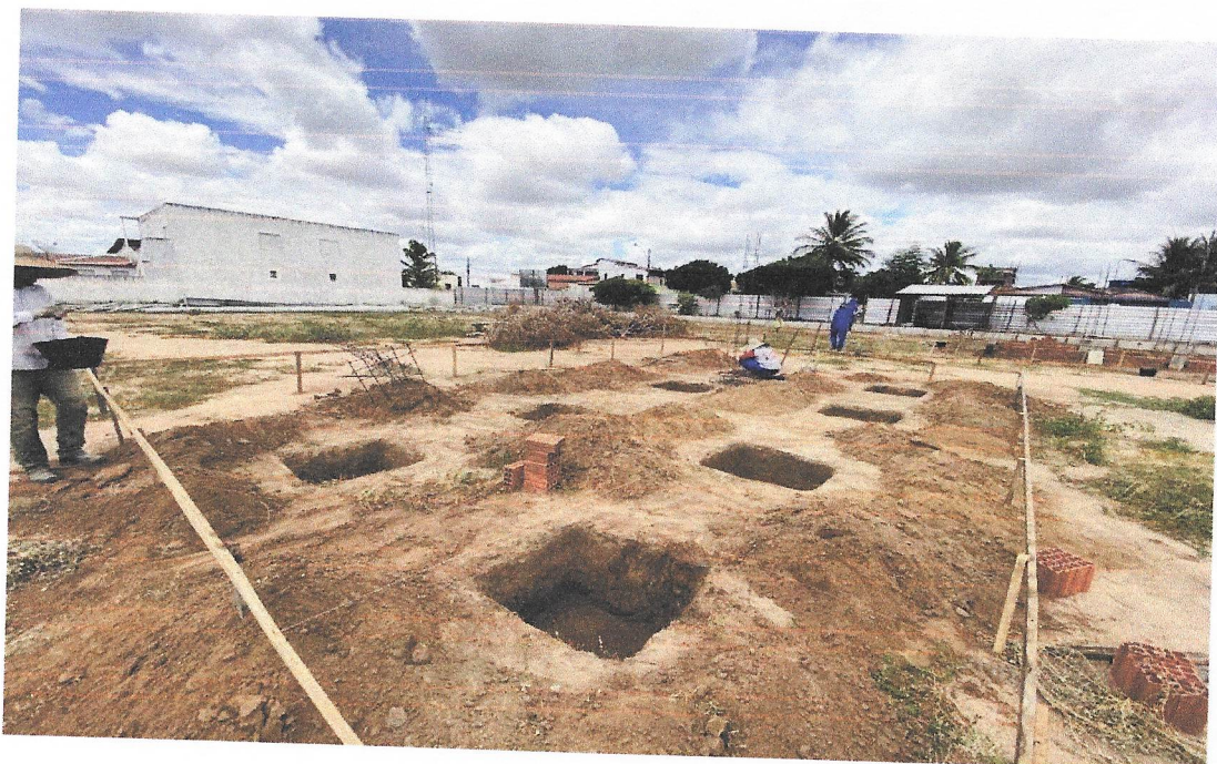
Foto 02 – ESCAVAÇÃO MANUAL PARA BLOCO DE COROAMENTO OU SAPATA.
