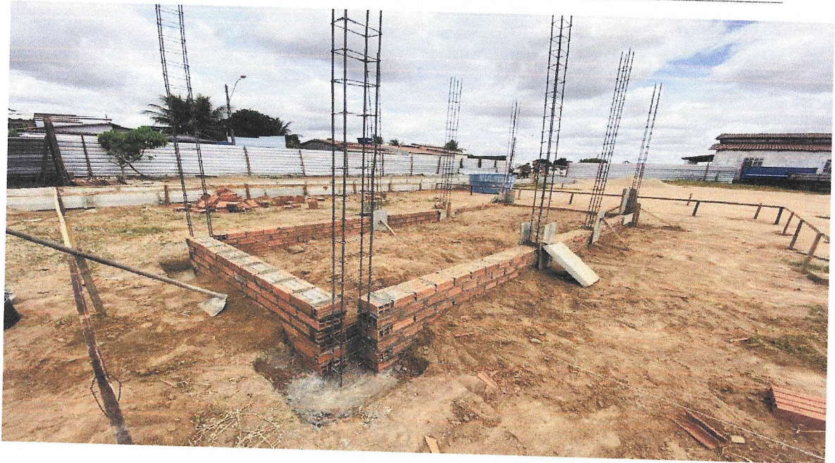
Foto 05 – EXECUÇÃO DE ESTRUTURAS DE CONCRETO ARMADO, PARA EDIFICAÇÃO HABITACIONAL UNIFAMILIAR TÉRREA.
