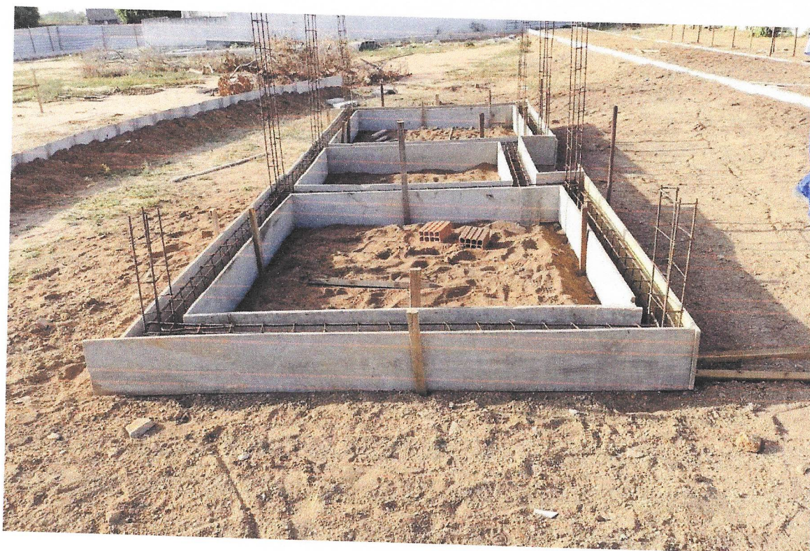
Foto 08 – COLOCAÇÃO DE FÔRMAS PARA VIGA BALDRAME.
