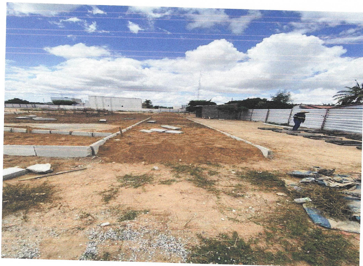
Foto 19 - ATERRO MANUAL DE VALAS COM AREIA PARA ATERRO E COMPACTAÇÃO MECANIZADA.
