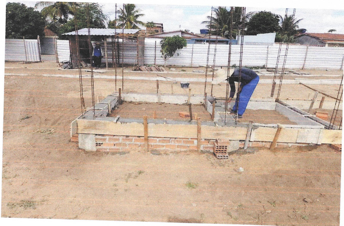
Foto 14 – EXECUÇÃO DE ESTRUTURAS DE CONCRETO ARMADO.
