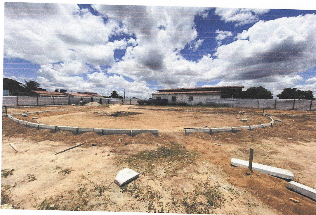
Foto 11 – ASSENTAMENTO DE GUIA (MEIO-FIO) EM TRECHO RETO, CONFECCIONADA EM CONCRETO PRÉ-FABRICADO.
