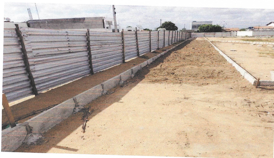
Foto 10 – ASSENTAMENTO DE GUIA (MEIO-FIO) EM TRECHO RETO, CONFECCIONADA EM CONCRETO PRÉ-FABRICADO
