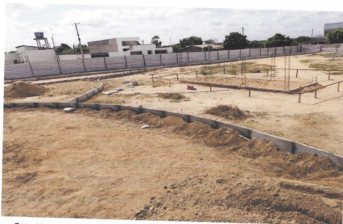
Foto 12- ASSENTAMENTO DE GUIA (MEIO-FIO) EM TRECHO RETO, CONFECCIONADA EM CONCRETO PRÉ-FABRICADO.
