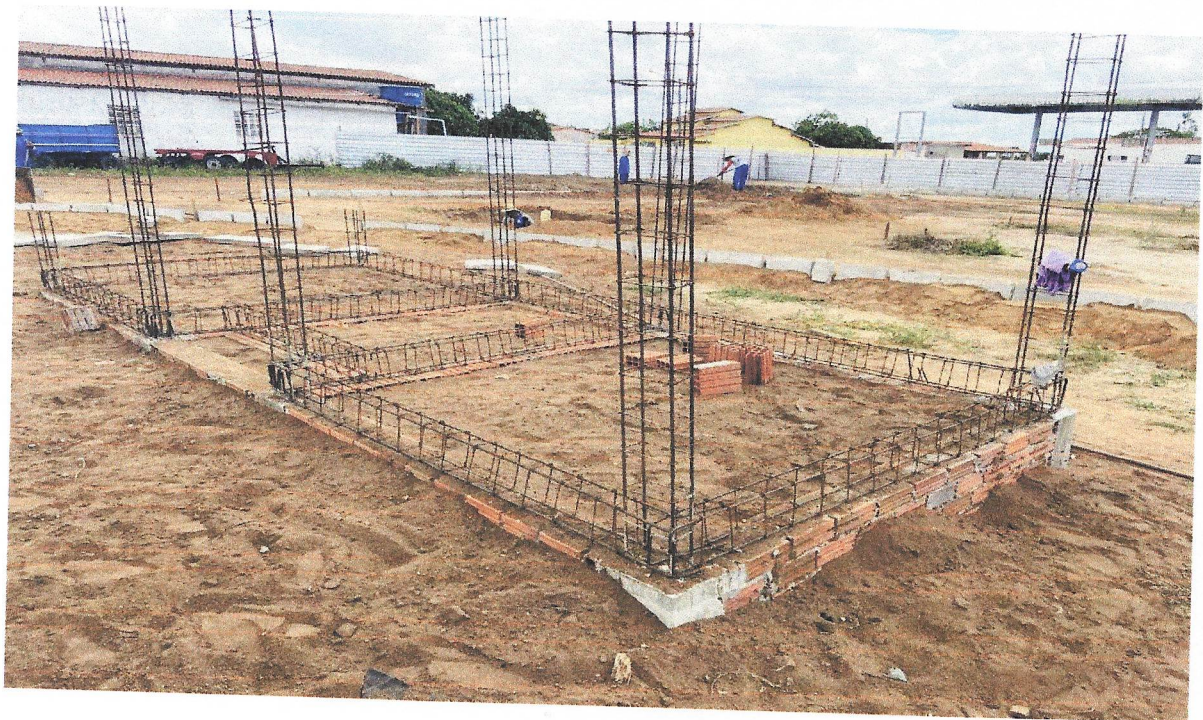
Foto 06 – EXECUÇÃO DE ESTRUTURAS DE CONCRETO ARMADO, PARA EDIFICAÇÃO HABITACIONAL UNIFAMILIAR TÉRREA
