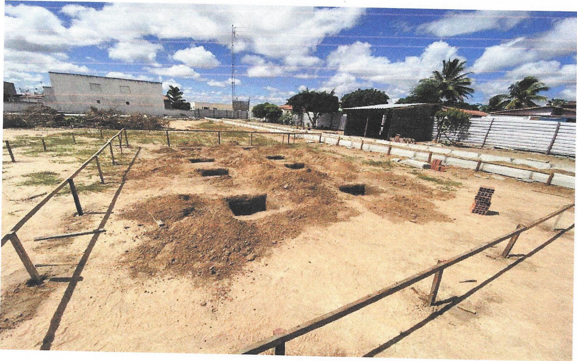
Foto 03 – ESCAVAÇÃO MANUAL PARA BLOCO DE COROAMENTO OU SAPATA
